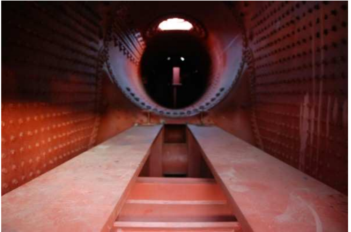
Fot. 1) Wnętrze kotła parowozu Ty2-1035– puste i pozbawione elementów, jak ściany sitowe, płomienice i płomieniówki. Widok od strony skrzyni ogniowej, która została zniszczona poprzez wsunięcie w jej środek dwóch belek stalowych ze sobą połączonych.
