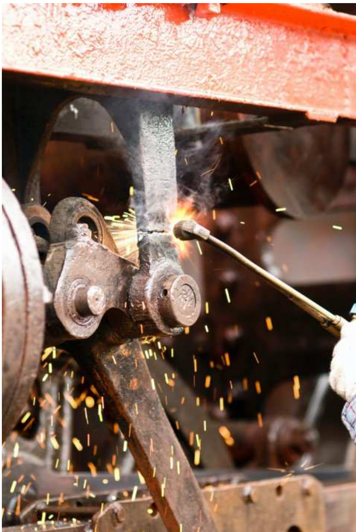
Fot. 3 )Wycinane palnikiem elementy w parowozie Ty2-1035. - marzec 2009 r.
